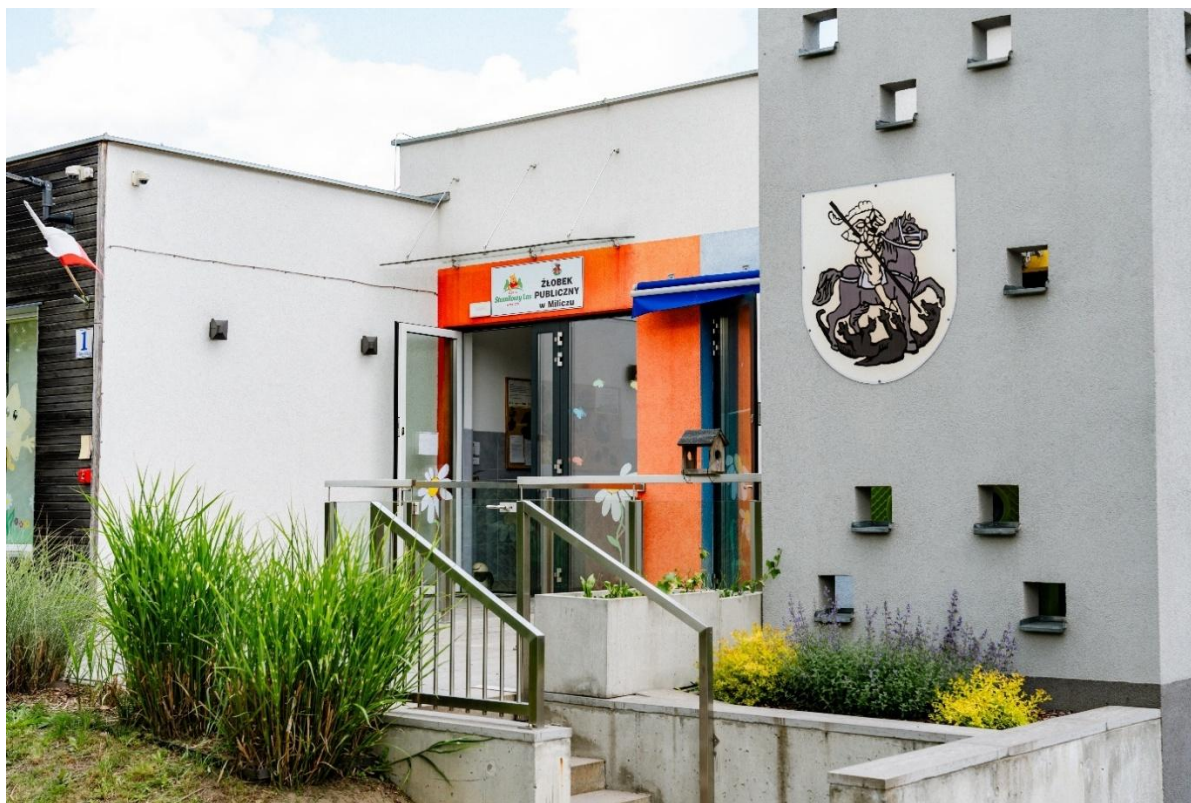
Budynek Żłobka Publicznego w Miliczu
