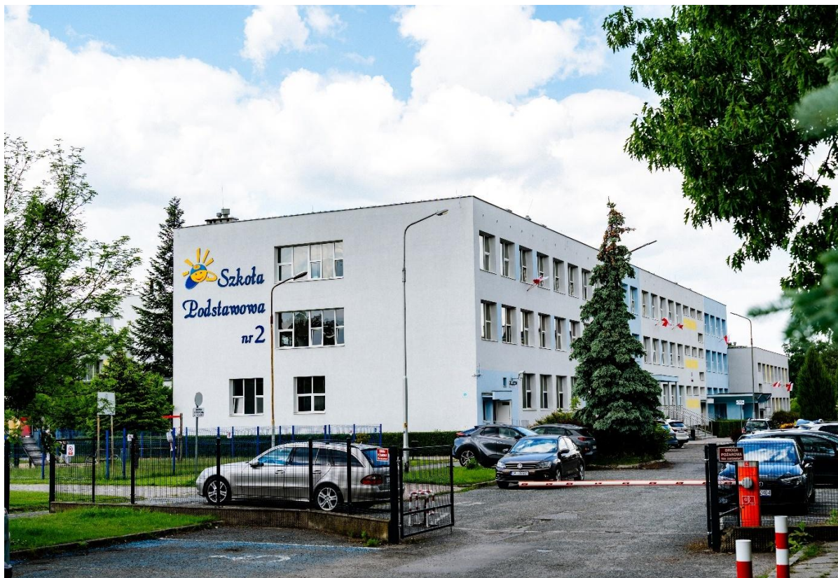
Budynek Szkoły Podstawowej nr 2 w Miliczu
